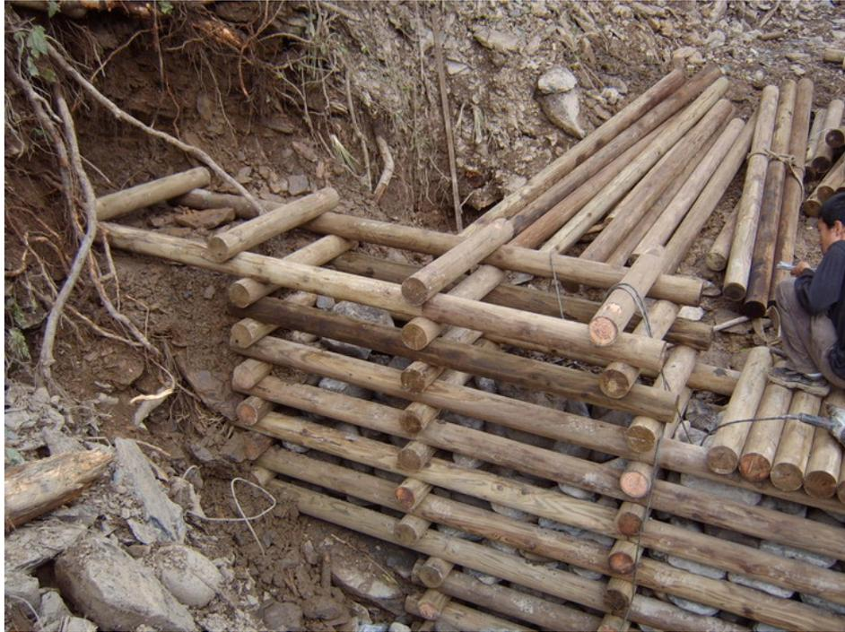
圖 63、1 號節制壩邊緣與坡面
