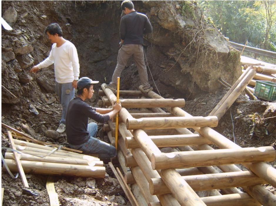
圖 59、1 號節制壩組裝時依圖面尺寸確定裝設位置
