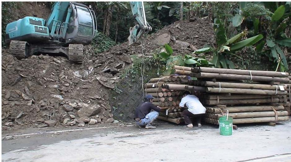
圖 36、2 號節制壩 O&D 防腐處理圓木棒進場 1
