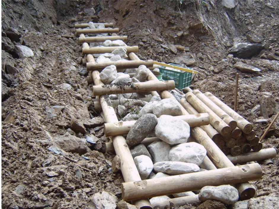
圖 49、2 號節制壩組裝過程不斷填土與石礫 2
