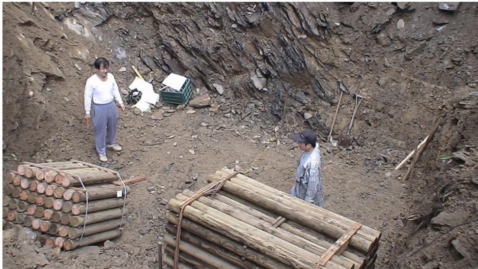
圖 38、2 號節制壩 O&D 防腐處理圓木棒進場 3
