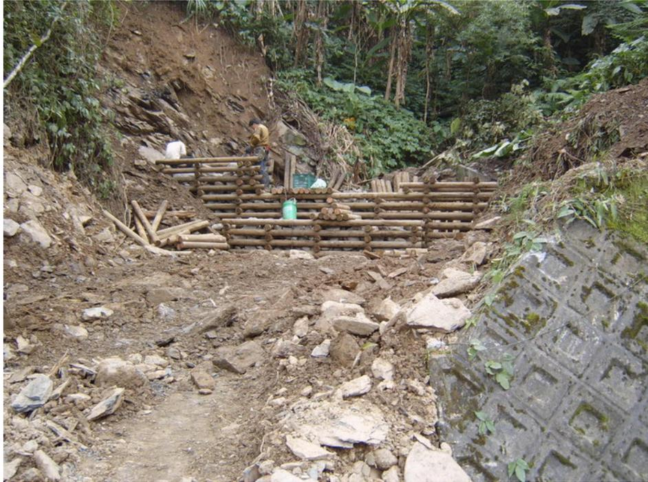
圖 51、2 號節制壩體外觀已具雛形
