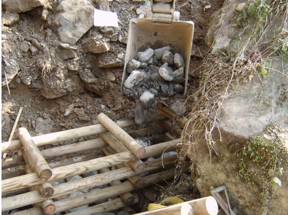
圖 61、1 號節制壩組裝過程隨時填土與石礫
