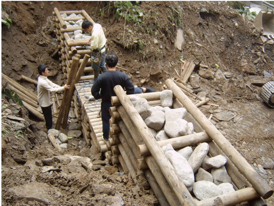
圖 52、2 號節制壩邊緣部分填土與石礫
