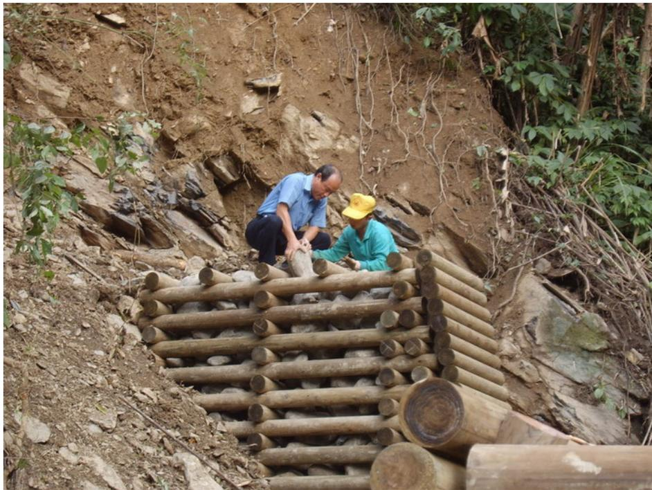
圖 66、1 號節制壩回填石礫
