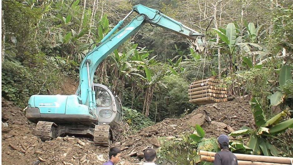
圖 37、2 號節制壩 O&D 防腐處理圓木棒進場 2
