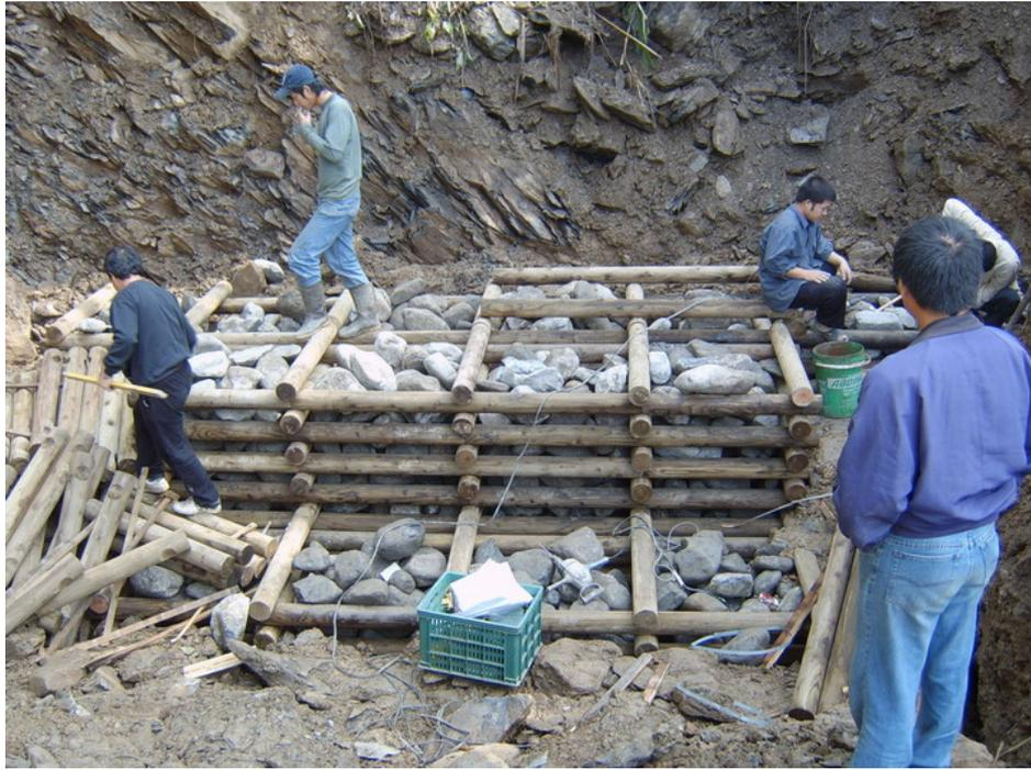
圖 47、2 號節制壩基礎填土與石礫後持續組裝
