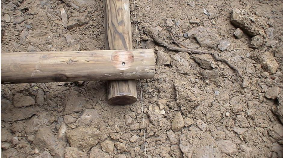
圖 39、2 號節制壩基礎定位
