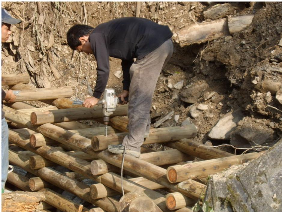
圖 60、1 號節制壩以熱浸鍍鋅木螺釘固定
