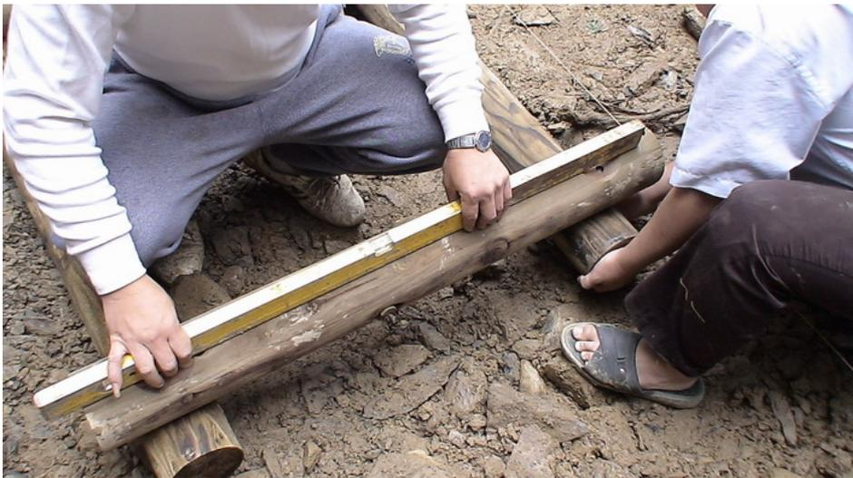
圖 40、2 號節制壩基礎定位後丈量
