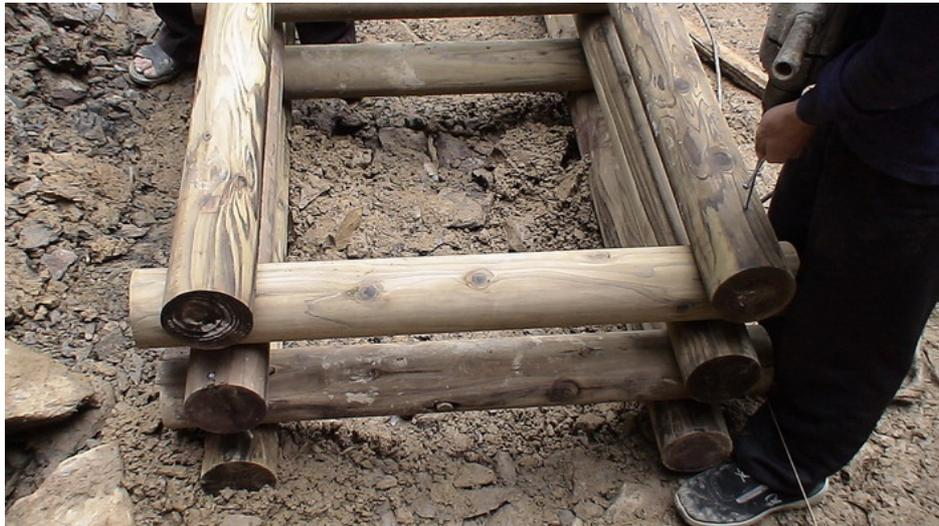
圖 42、2 號節制壩 A 區基礎定位後逐層組立
