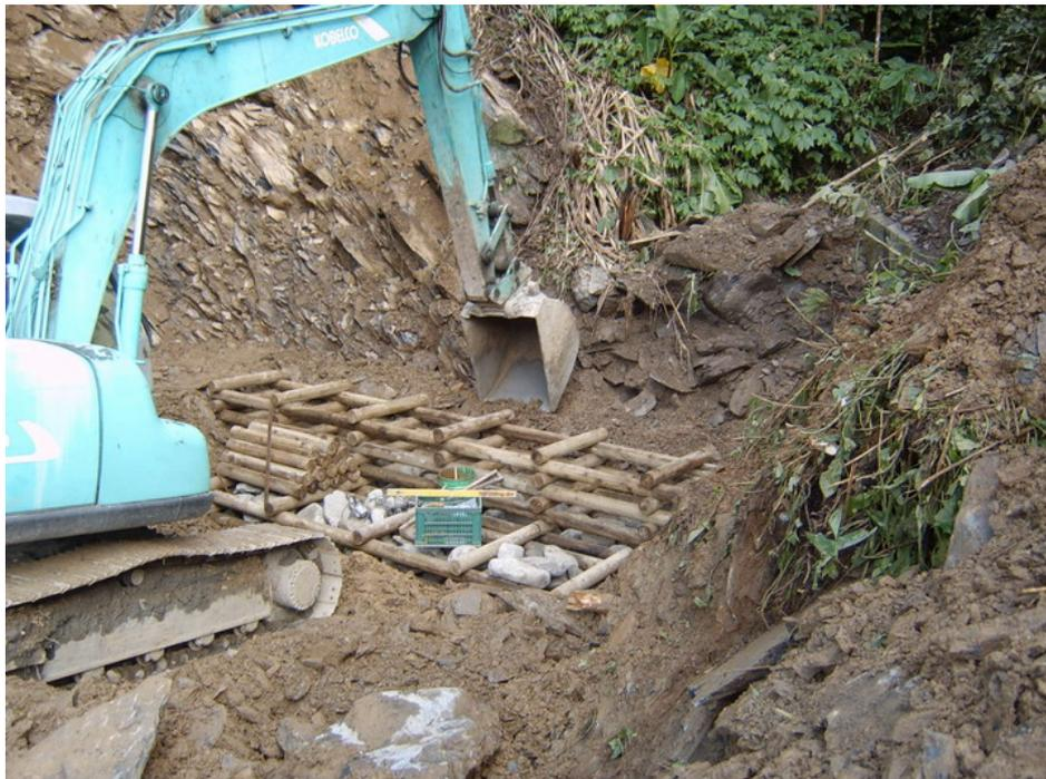
圖 48、2 號節制壩組裝過程不斷填土與石礫 1
