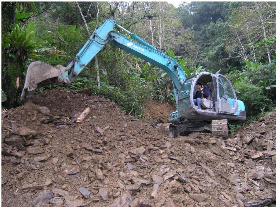
圖 30、挖土機整地挖土、石 2
