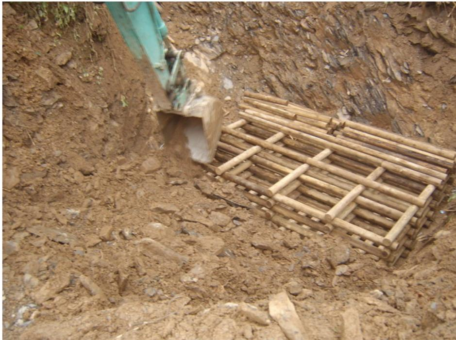
圖 46、2 號節制壩基礎至預定高度先填土與石礫
