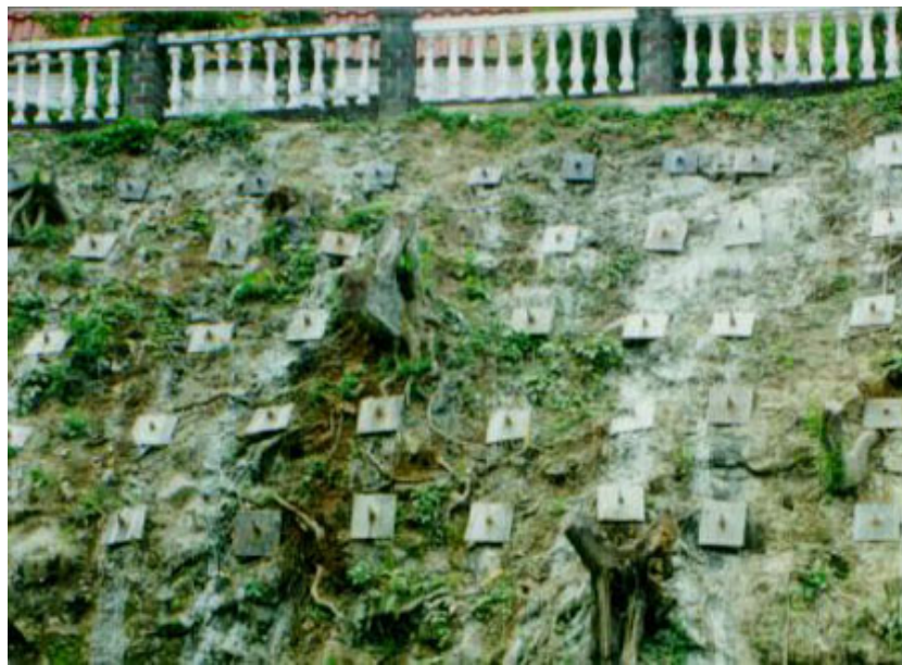
圖 4.6-16 土釘鑽設和承載鈹鎖定完成之情形(洪勇善攝)
