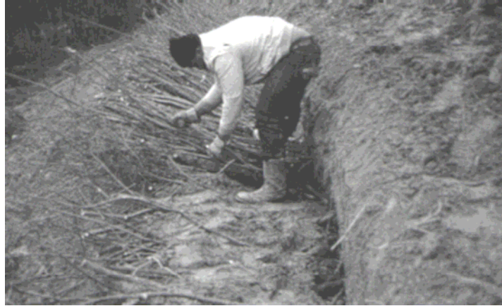
圖4.6-3 切枝壓條法施工案例 (Gray and Sotir, 1996)
