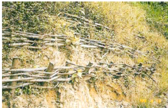
圖4.6-6 打樁編柵法施工案例 (廖瑞堂, 2001)
