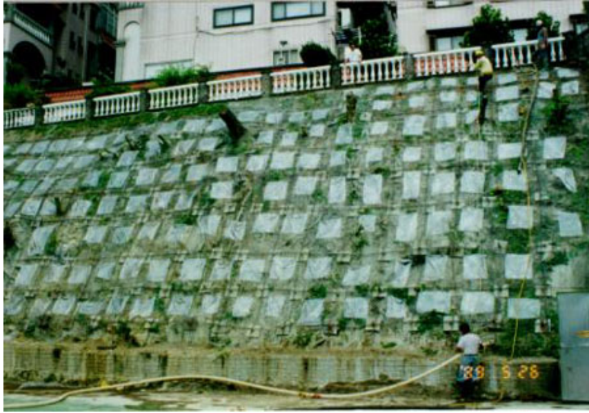
圖 4.6-17 鋪設格框與塑膠布之施工情形(洪勇善攝)
