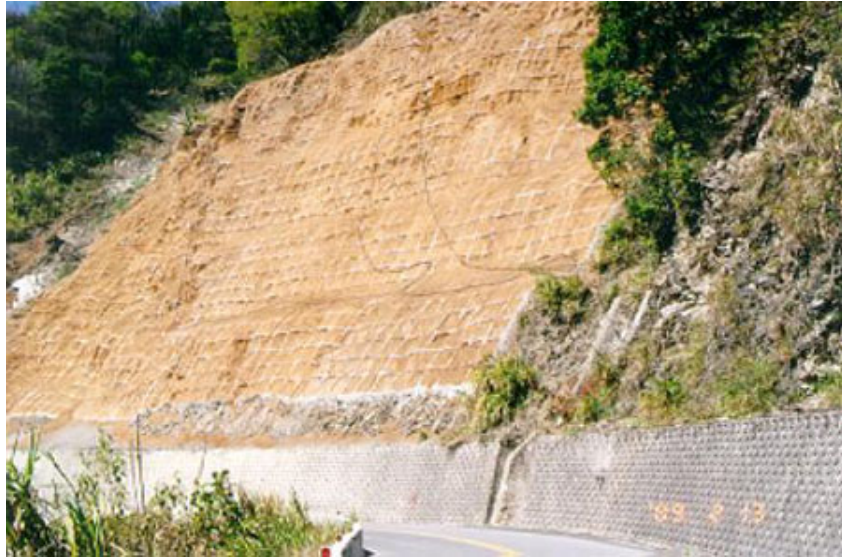
圖 4.6-15 格框噴植法完成後之情形(洪勇善攝)
