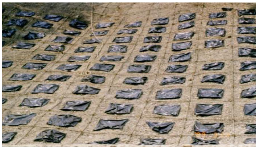
圖 4.6-14 格框噴植法施工情形(洪勇善攝)
