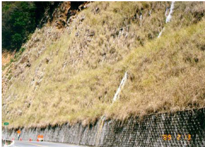
圖 4.6-15 型框植生工法完成半年後之情形(洪勇善攝)
