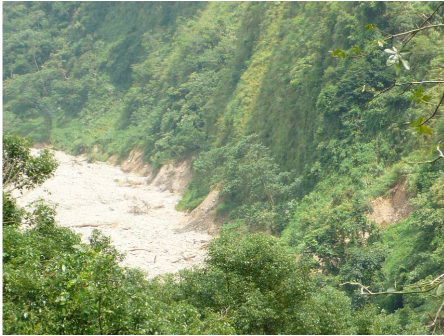
圖 78 乾溪上游河岸側蝕所產生的小規模崩塌及岩層裸露（226973,2656046）
