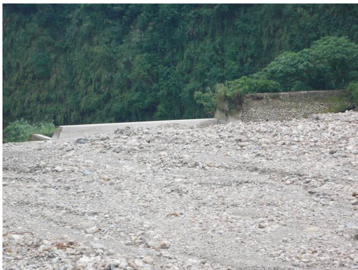
圖 75 乾溪上、中、下游攔砂壩土石堆積情形
