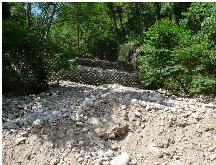
圖 77 辛樂克颱風後大量土石沿沖蝕溝被帶出 (227634,2655270)
