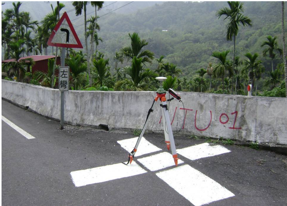
圖 53 NTU01 控制點 GPS 測量
