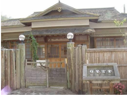
日式警舍部落分駐所舊式建築
