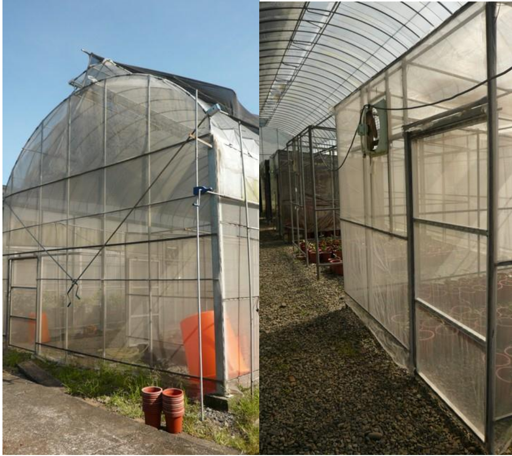
圖 6 試驗溫室外觀與內部各種不同遮陰處理的小溫室。
