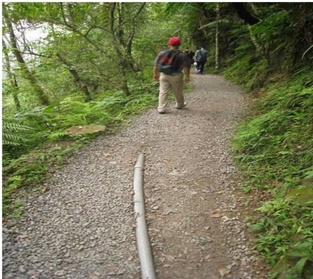
圖 16 步道土壤沖蝕造成埋在地下的 高爾夫球場水管裸露（林美石磐步道）
