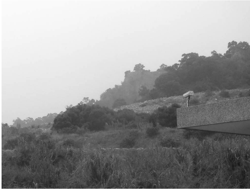
圖 9 火炎山隧道東口監視器架設位置 ( 2007/9/12 )
