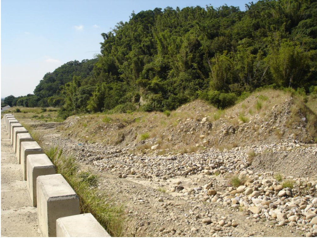
圖 67 隧道西口旁的滯洪池
