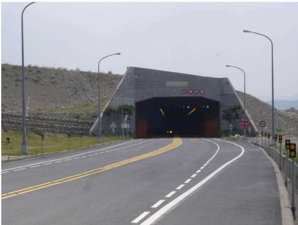
圖 8 完工後的火炎山隧道口 ( 拍攝日期：2006/2/28 )
