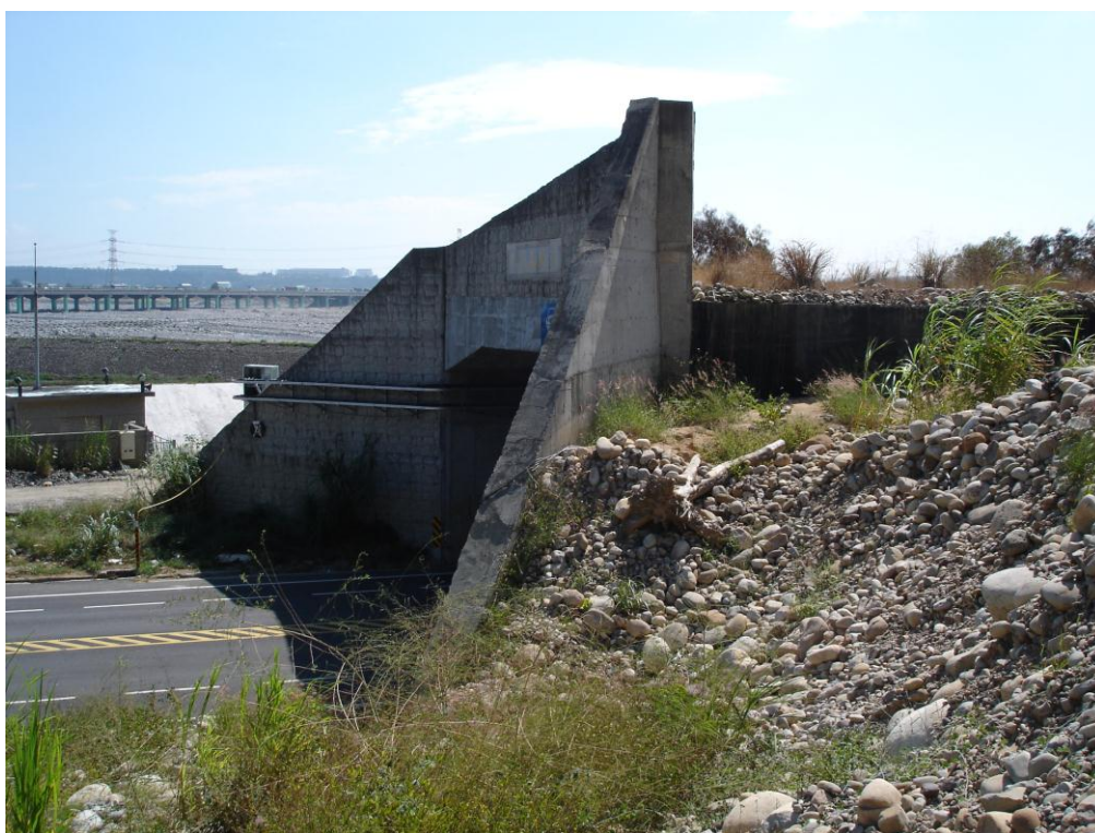
圖 53 莫拉克颱風後火炎山隧道東口情況 2
