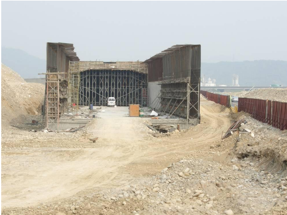
圖 7 施工中的火炎山隧道口 ( 拍攝日期：2005/4/5 )
