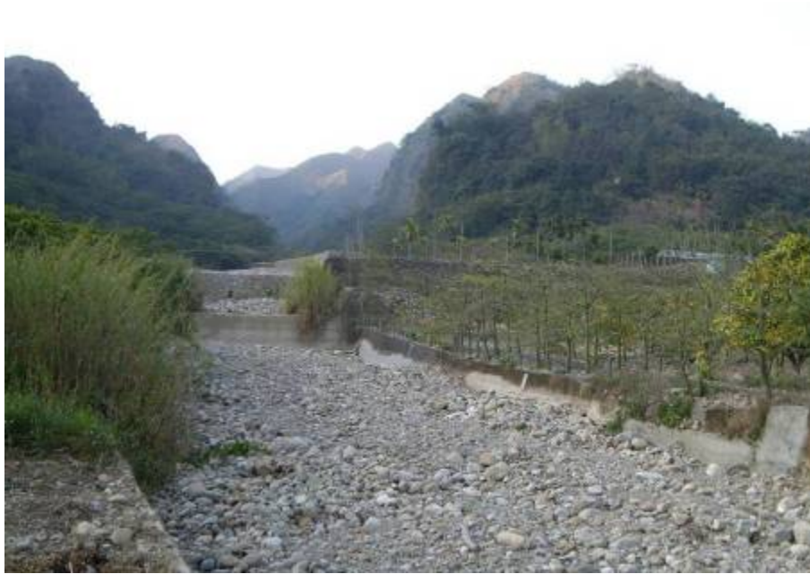
圖 32 田尾坑溪下游攔砂壩堆積情形（229778,2654944）
