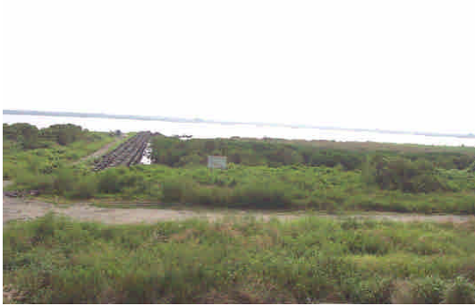
照片 1：高屏溪口紅樹林復育區
