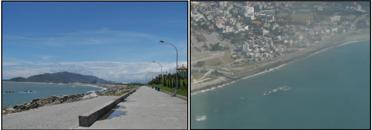
照片4-1 南濱岸邊消波塊設置狀況
