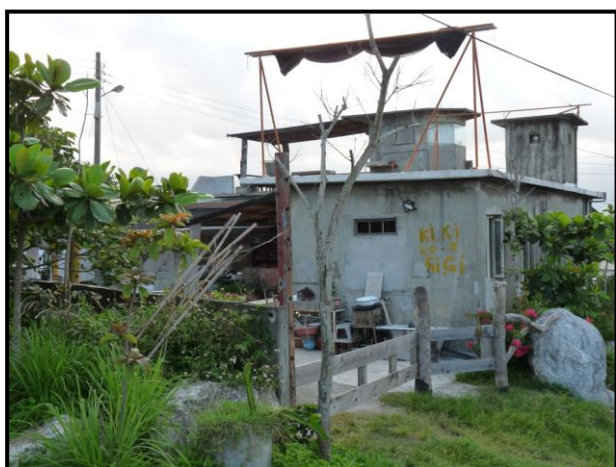
照片 5-7 2635 號違建情形
