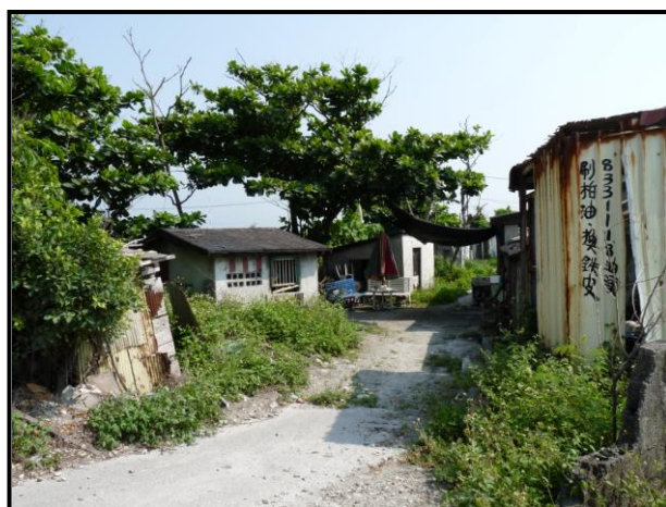
照片 5-6 2602 號違建情形(二)
