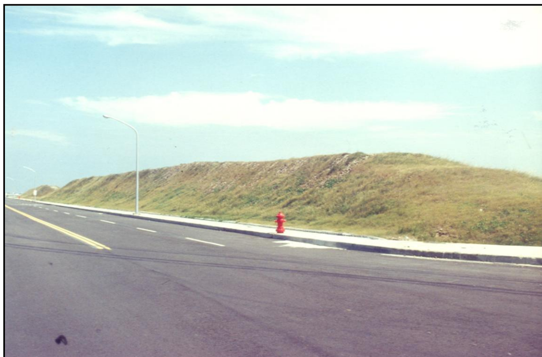
照片 5-1 彰濱工業區鹿港沿海防風土堤設施
