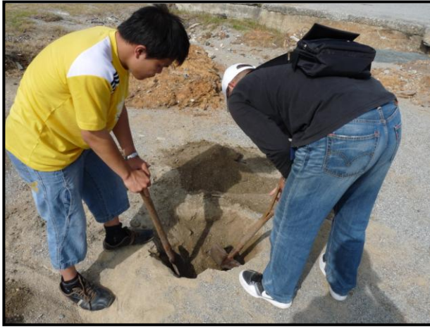
照片 4-4 DTR 埋設情形(1)
