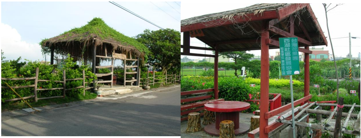
圖 12. 埔北社區與西湖社區利用漂流木及廢木料所搭建之涼亭
