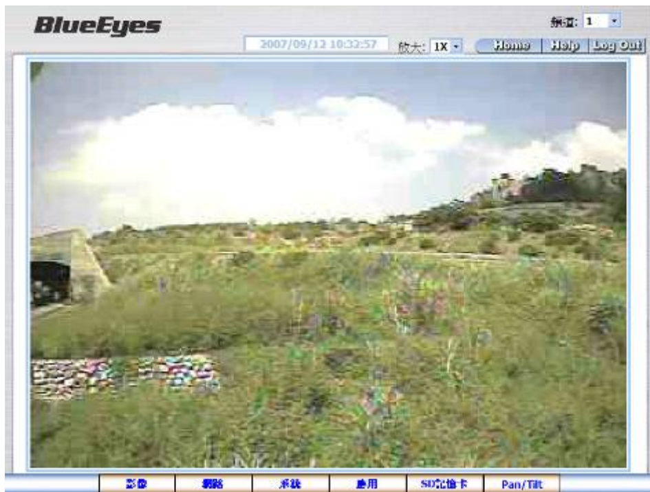
圖 4.4 火炎山隧道東口監視系統介面 (2007/9/12)
