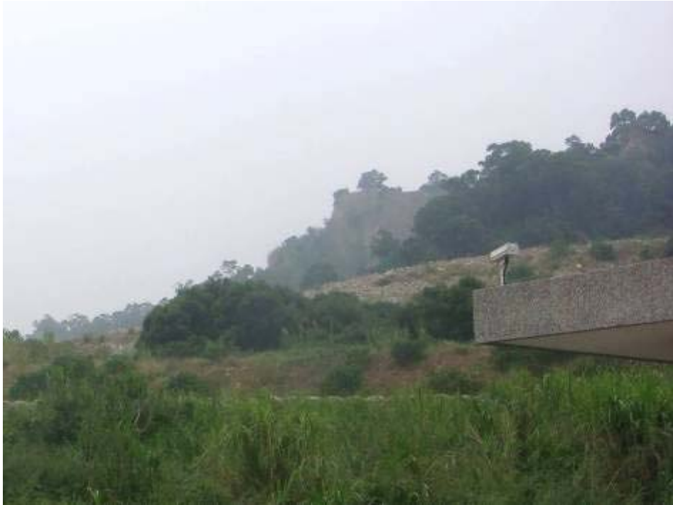
圖 4.3 火炎山隧道東口監視器架設位置 (2007/9/12)
