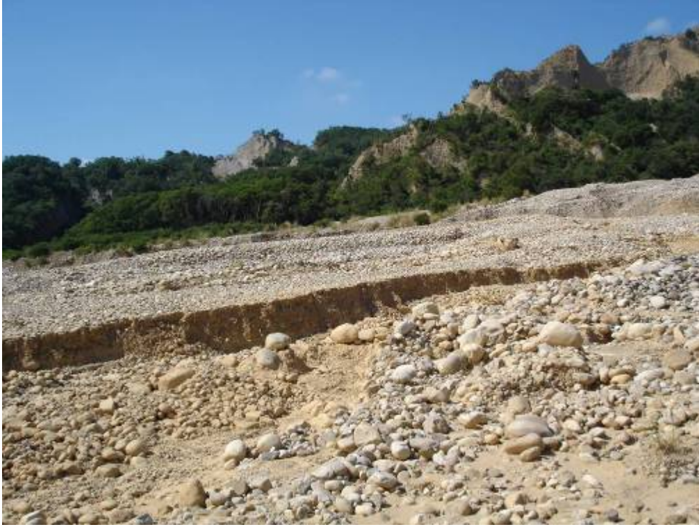
圖 5.38 3 號集水區扇面上的刷深情況
