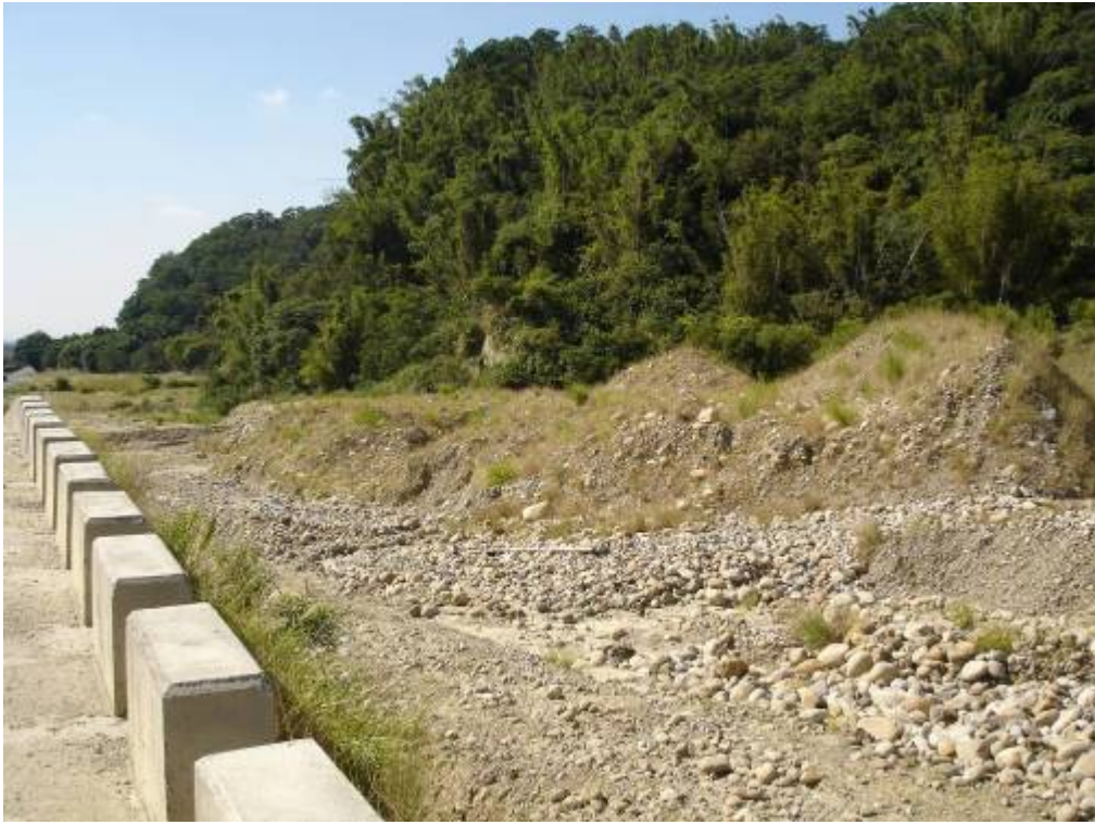
圖 5.45 隧道西口旁的滯洪池
