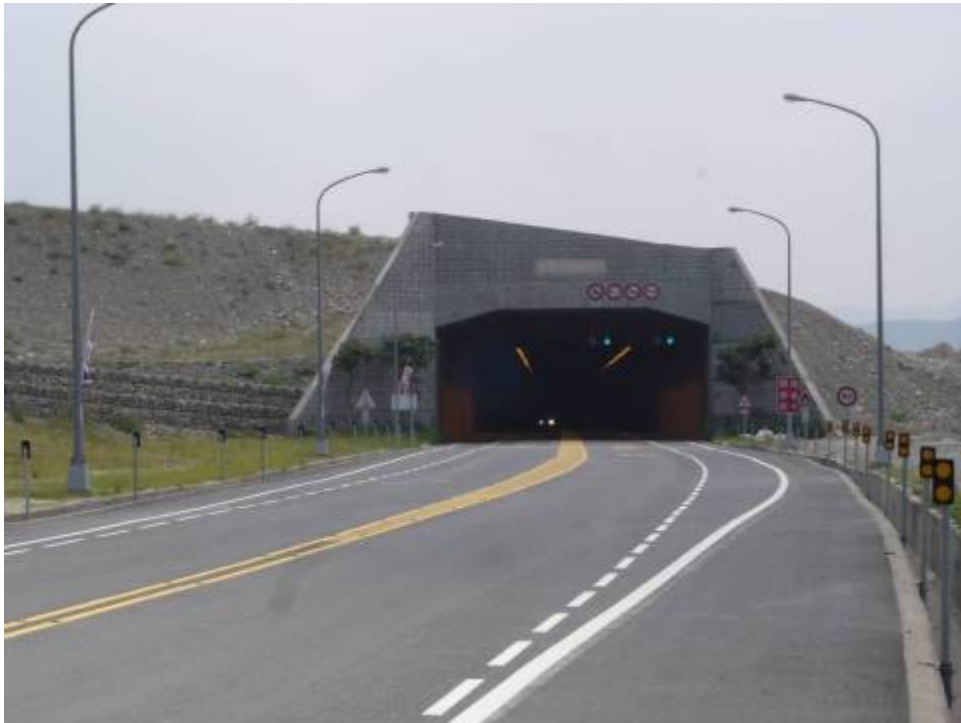
圖 2.8 完工後的火炎山隧道口（拍攝日期：2006/2/28）
