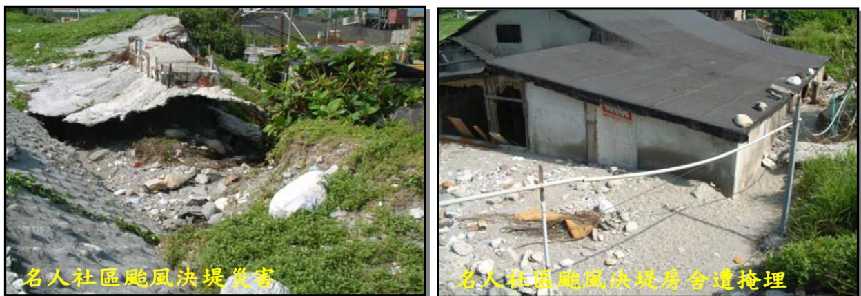
照片 4-6 颱風侵襲後災損情形
