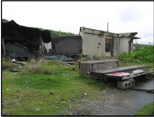
照片5-5 2613號違建拆除基地
