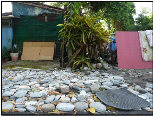
照片 5-7 2618 號違建情形
