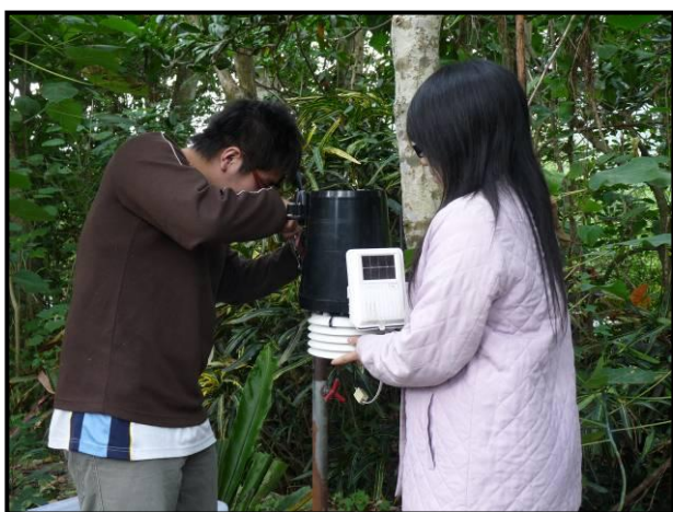
照片 4-11 Davis 微氣候儀器架設情形
