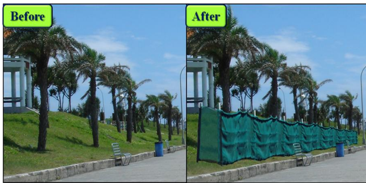
照片 5-12 2602 號飛砂防止保安林之防風網施設前後示意對照圖
