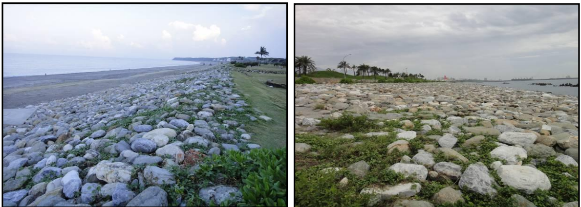
照片4-1 七星潭與南濱海岸防護設施設置狀況
