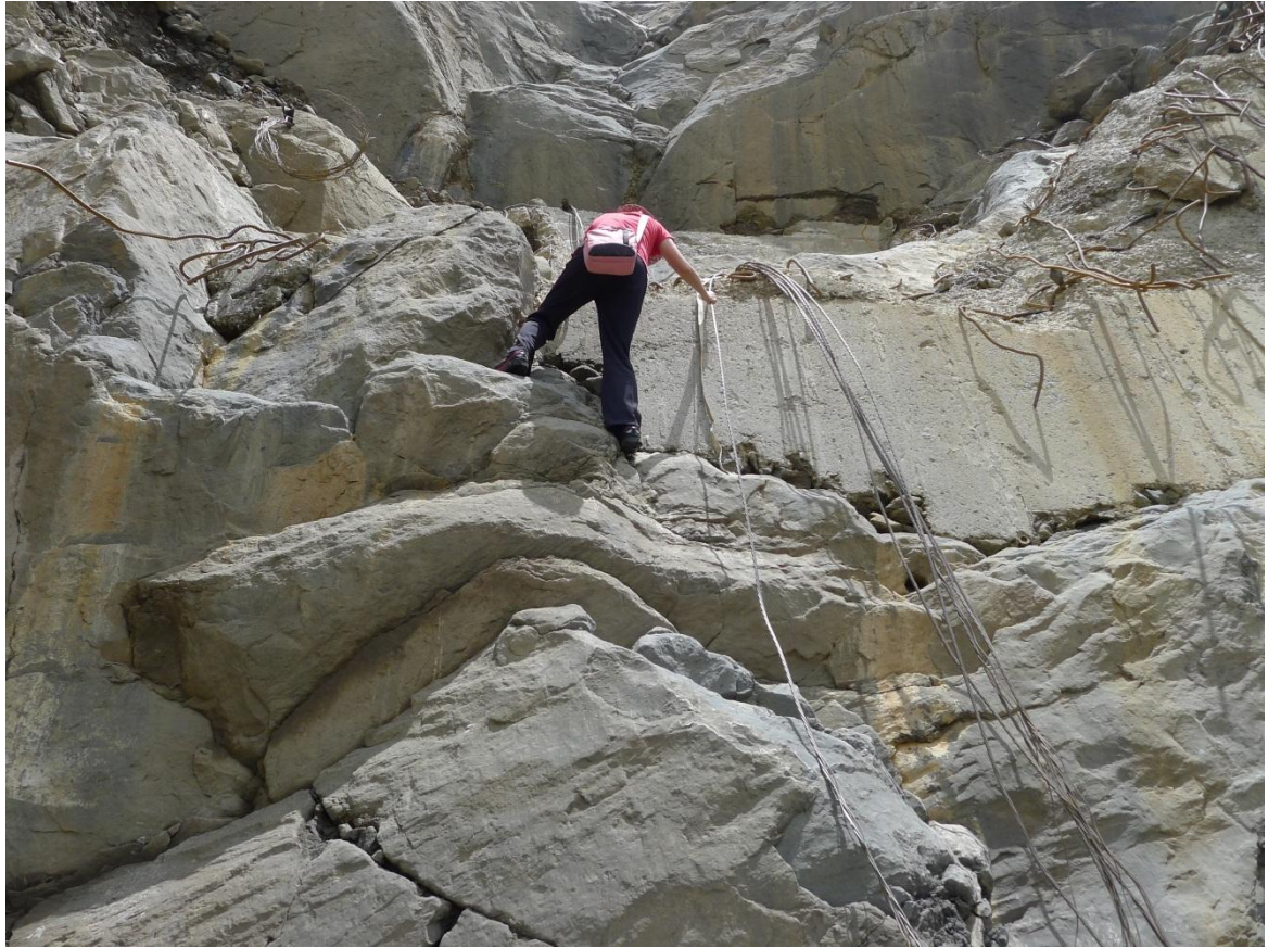
圖 26. 今年七月，整個碎石被沖光，僅剩鋼調外露。
