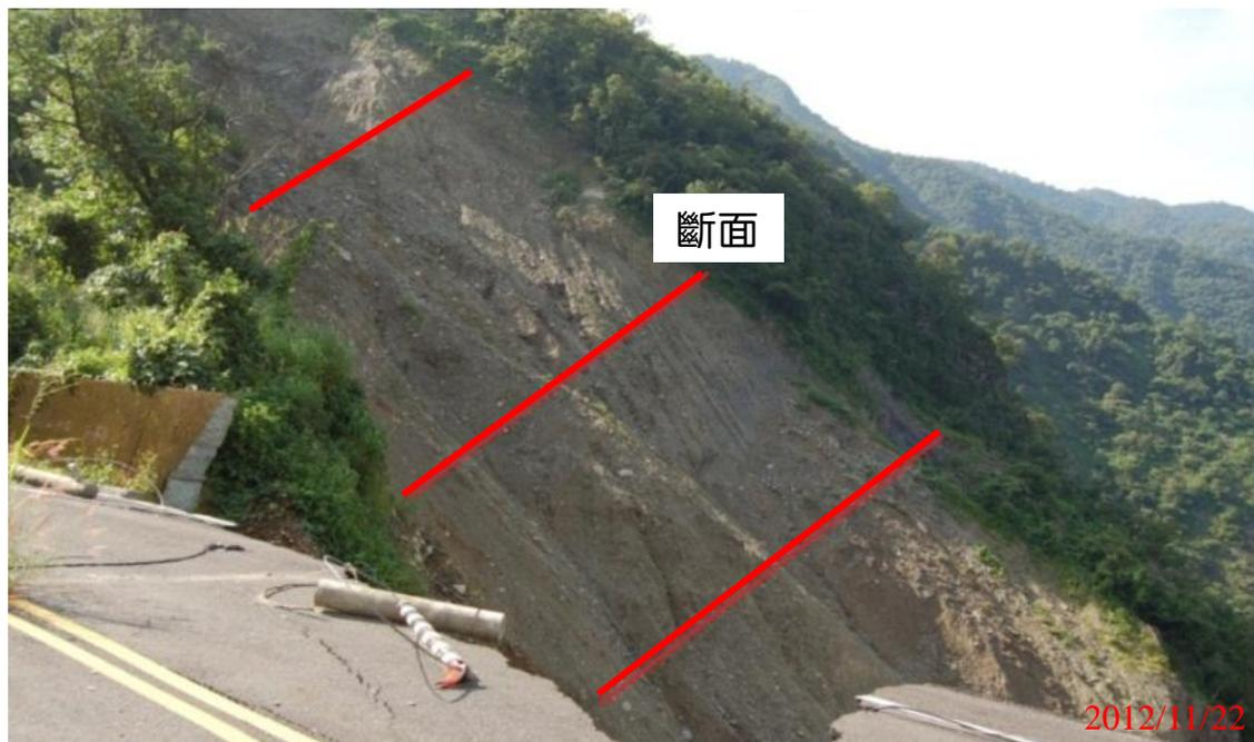
圖 4-1-2 崩塌地橫斷面量測法
