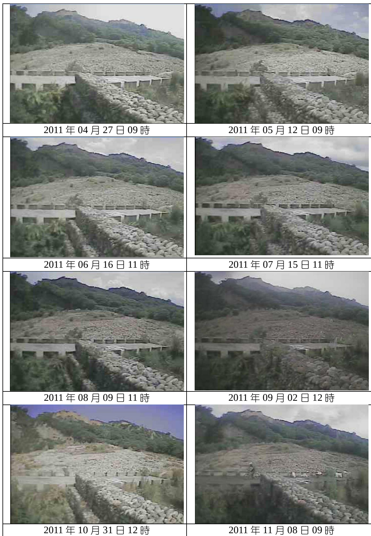
圖 4.60 2011 年火炎山隧道西側監視影像
