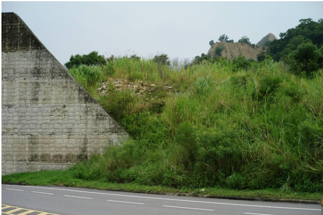
圖 4.78 隧道東口的邊坡（2012 年 8 月 3 日）
