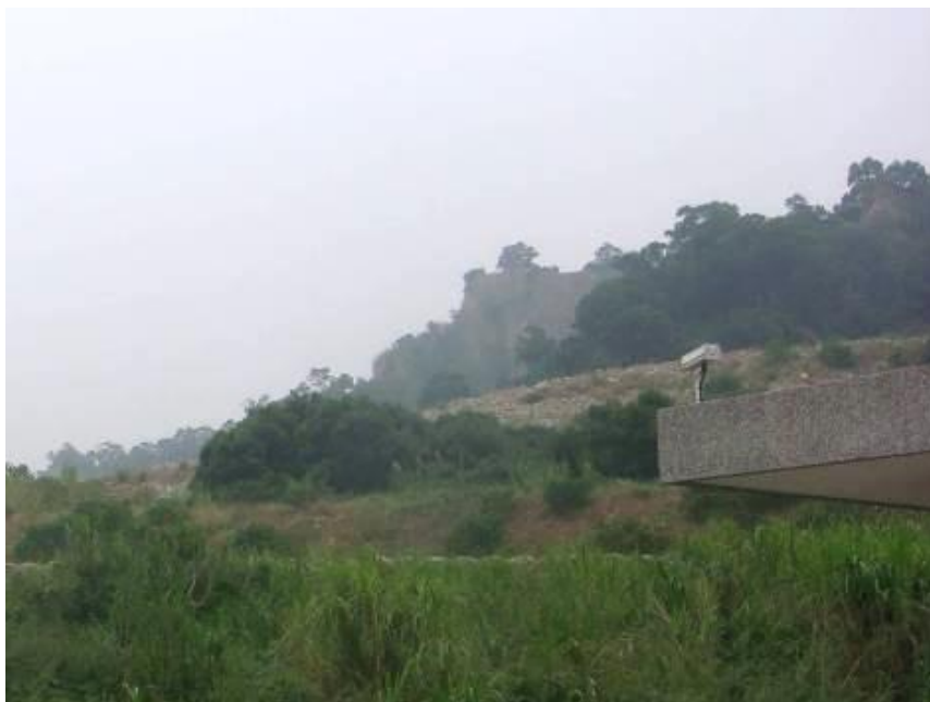
圖 3.15 火炎山隧道東口監視器架設位置（2007/9/12）
