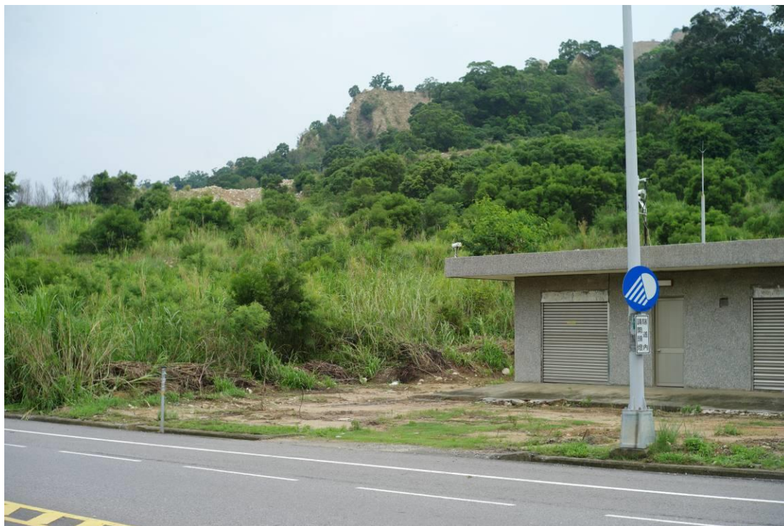
圖 4.79 在隧道東口旁的機房（2012 年 8 月 3 日）
