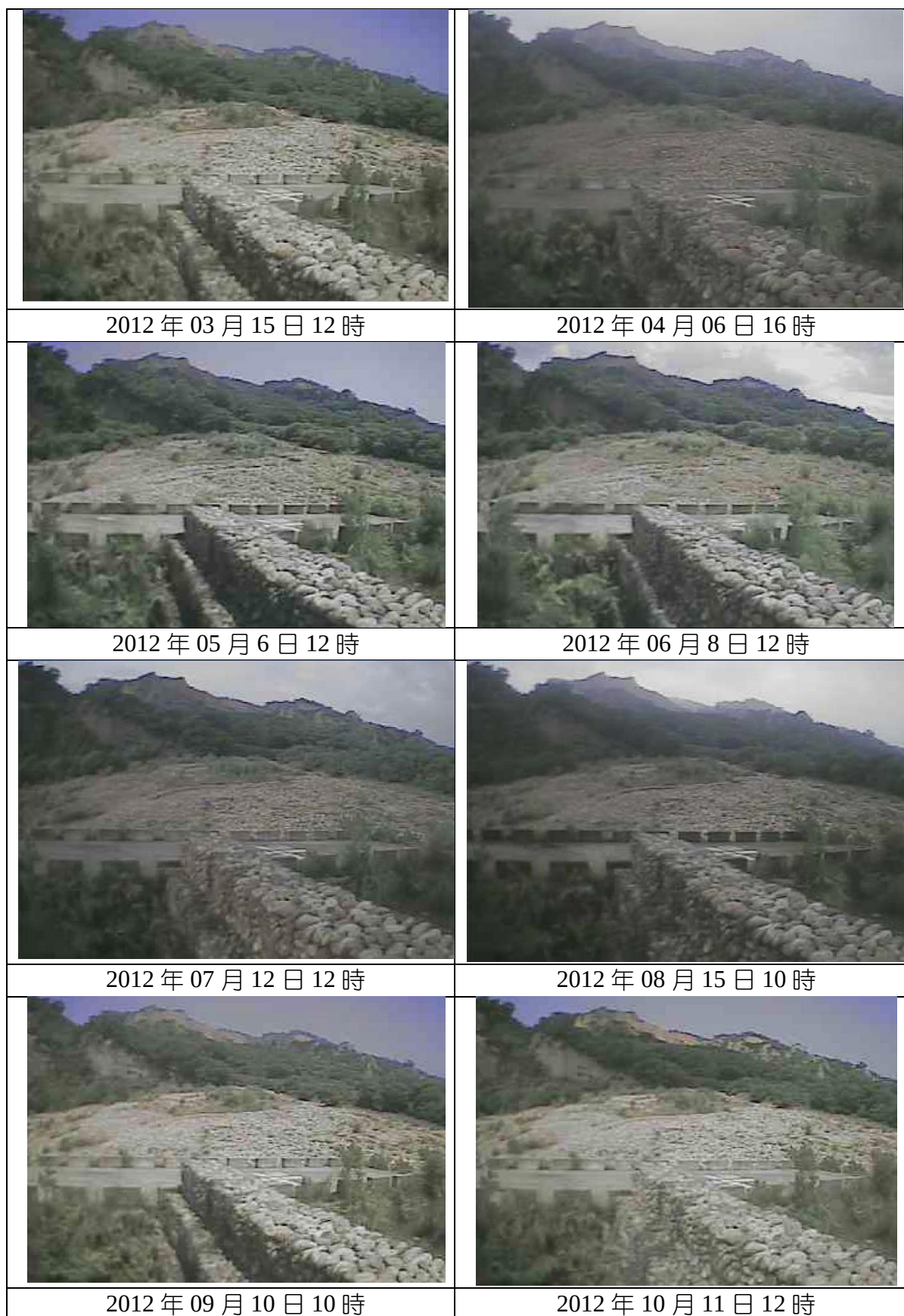
圖 4.61 火炎山隧道西側監視影像
