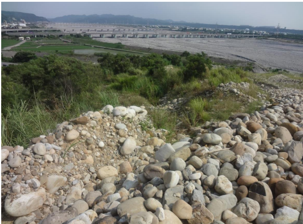
圖 4.88 1 號集水區東口隧道邊坡（2013 年 8 月 19 日）
