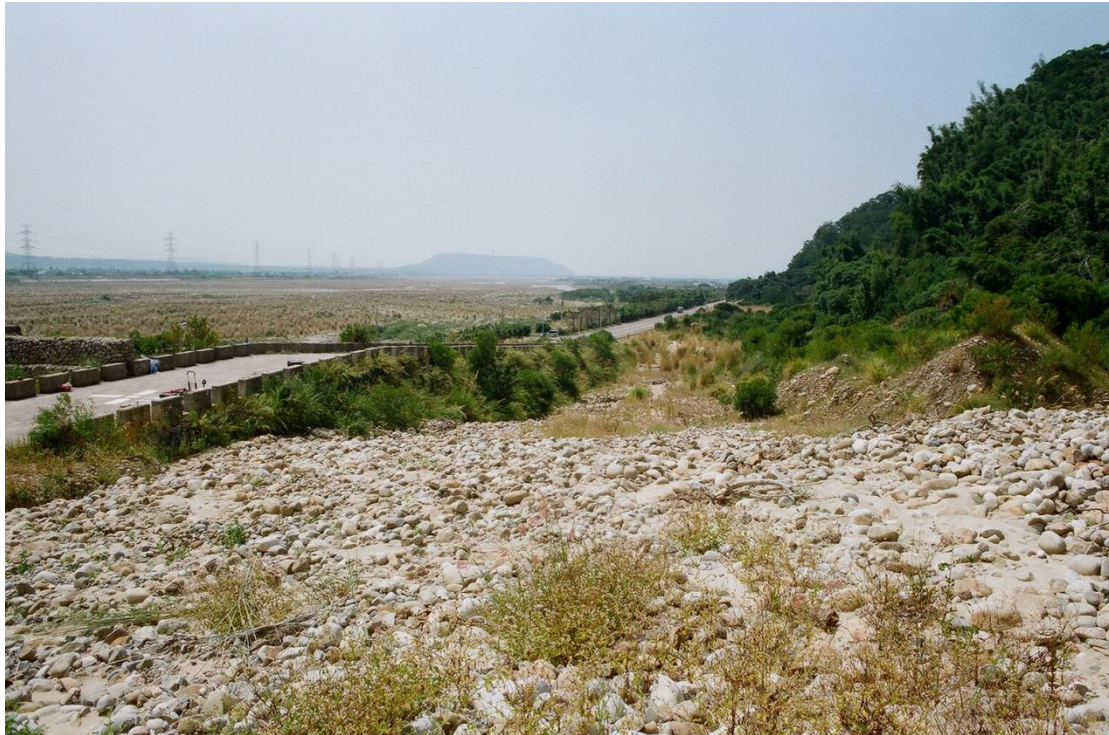
圖 4.67 5 號集水區下方土石溝（拍攝日期：2011 年 9 月）
