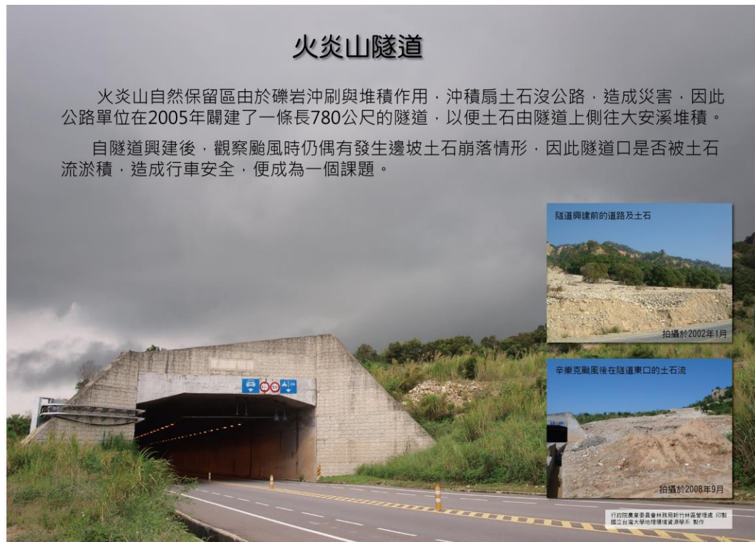
圖 4.99 火炎山隧道解說牌
