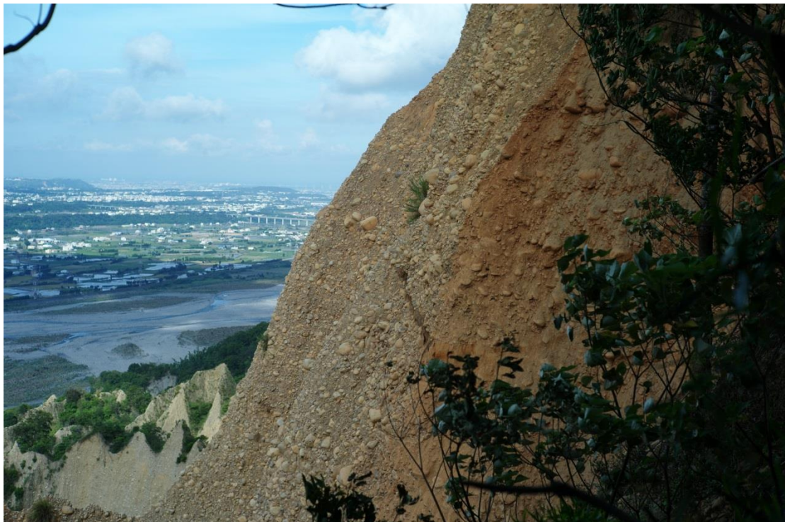
圖 4.74 在陡坡上右側為新崩落岩層，是近期豪雨事件所產生的（2012 年 7 月 14 日）
