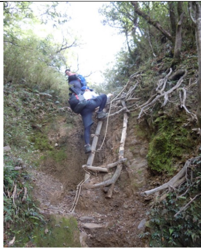
圖 4-64 木梯損壞情形
