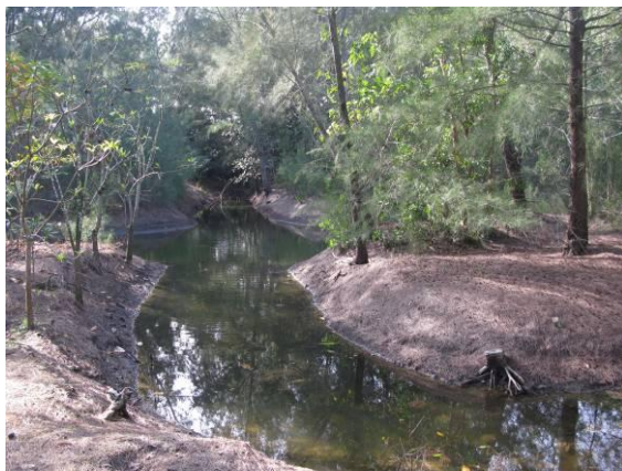
圖 6. 四湖工作站掘溝排水現況 1
