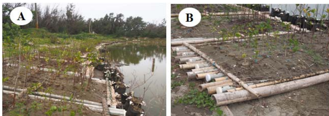
圖 20 (A)西側堤岸人工浮島，1 月完成栽植並假植於岸邊之情形；(B) 人工浮島介質上層覆蓋海砂。
