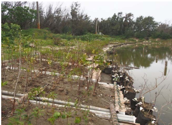
圖 17 進行修整舊有人工浮島 8 座。
