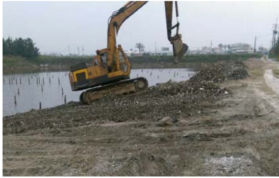
圖 4 展開南側塹堤整地作業。
