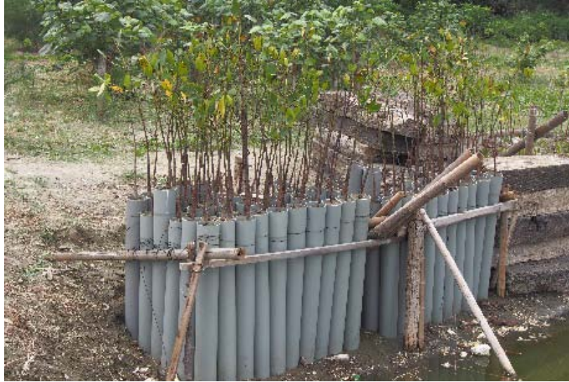
圖 16 假植岸邊之管柱(照片中水位過低)。
