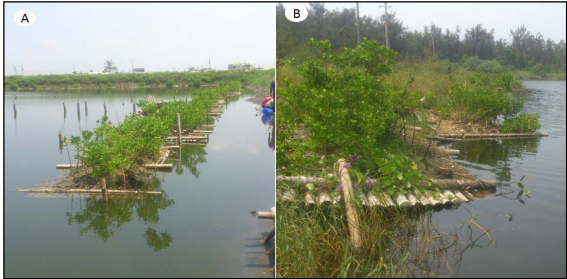
圖 5 (A)南側堤岸人工浮島初期完成之景觀；(B)颱風過後，南側堤岸人工浮島多受風吹擱淺岸邊，導致部分堤岸栽植之土沉香及使用美植袋栽植之親水植栽區受到損害。
