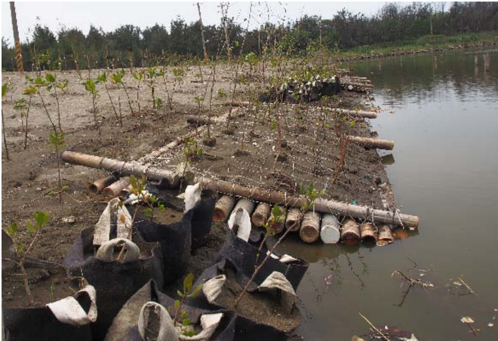
圖 3 美植袋與浮島間隔放置情形。
