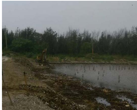
圖 9 海岸堆積蚵殼混砂丘土方回填。
