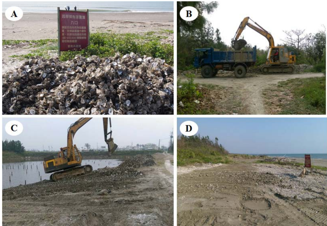
圖 17 (A)採集蚵殼來源之堆積場；(B)搬運海岸堆積蚵殼等回填材料；(C)展開南側塹堤整地作業；(D)採集蚵殼後之堆積場整地。
