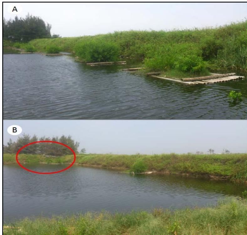
圖 3 (A)東側堤岸人工浮島初期完成之景觀；(B)颱風過後，東側堤岸僅剩 1 座人工浮島仍保持在原定位處，其餘 7 座則受風吹至紅圈處。
