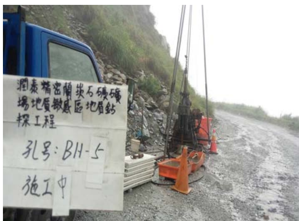
BH-5 號孔施工中照片
