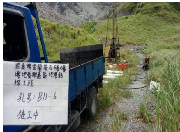
BH-6 號孔施工中照片
