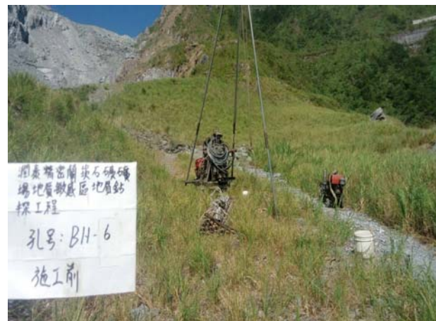
BH-6 號孔施工前照片
