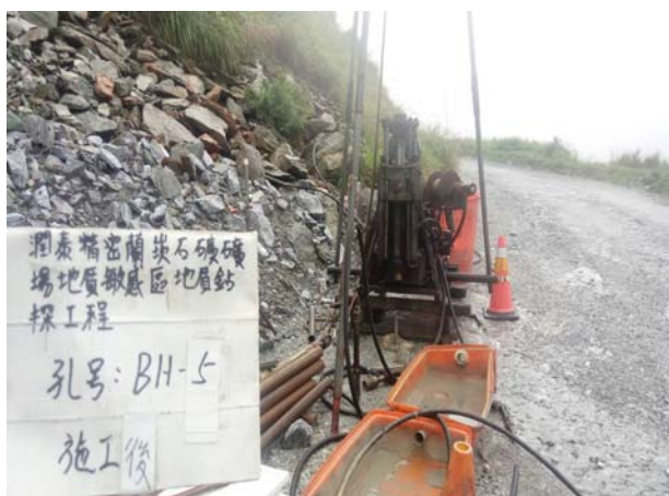
BH-5 號孔施工後照片
