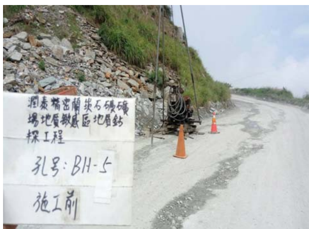
BH-5 號孔施工前照片
