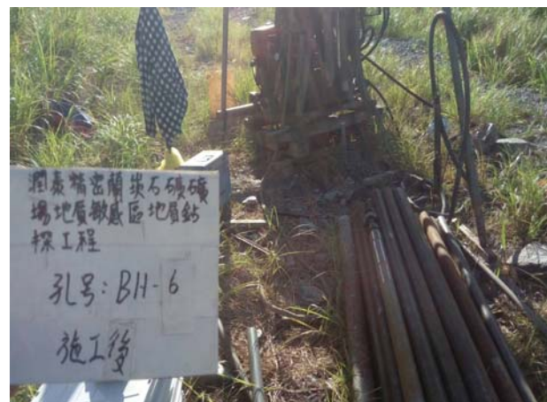
BH-6 號孔施工後照片
