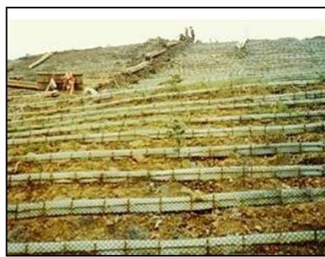
圖8-14 打樁編柵工法示意圖
