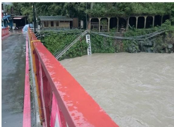
圖6-10 覽勝橋既有水尺及自計式水位計
