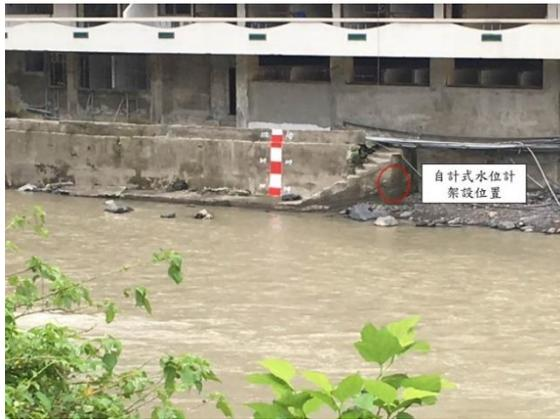
圖6-6 烏來橋水尺及自計式水位計位置
