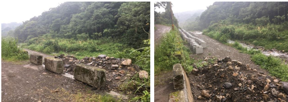
圖 7.2.3-9 橫流溪上游整治工程查核情形
