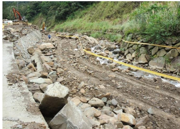
河道施工狀況
