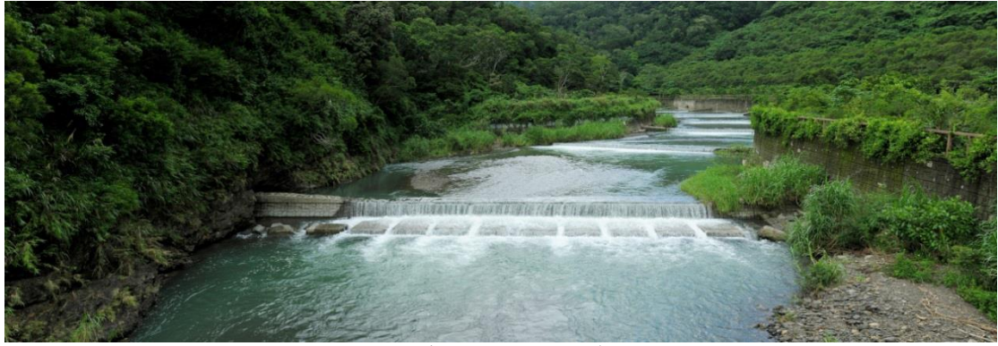
#1 雙溪橋上游固床工
