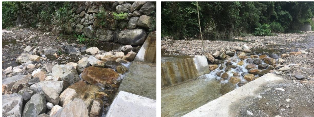
既有壩體開口並疊石改善落差
