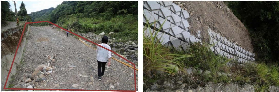
圖 7.2.3-6 橫流溪上游整治工程一工區施工便道與消能塊
