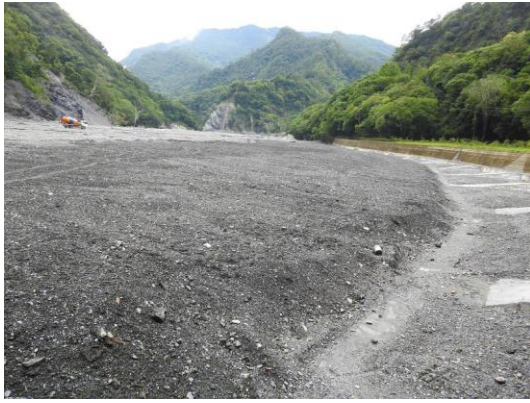
施工範圍復原情形
