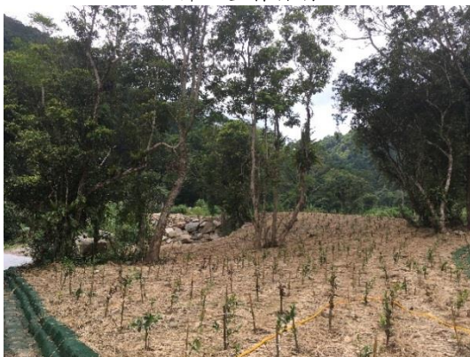
設計曲線護岸，完整保留樹群 1，樹群 1 下方原本雜草全清除，以人工種植含笑、薜荔等
