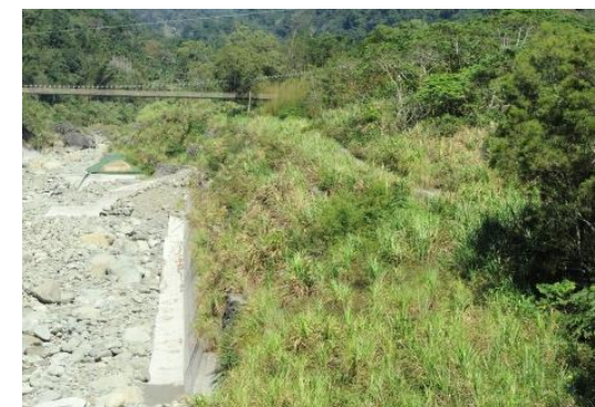
保全對象：沿岸相思樹芒草混生區域及左岸樹木儘可能保留
