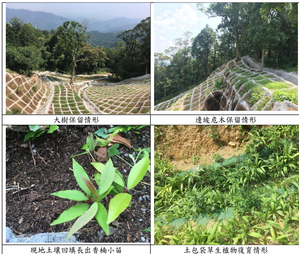
圖 7.2.1-3 石碇區風嘴崩塌地復育工程棲地完工階段狀況
