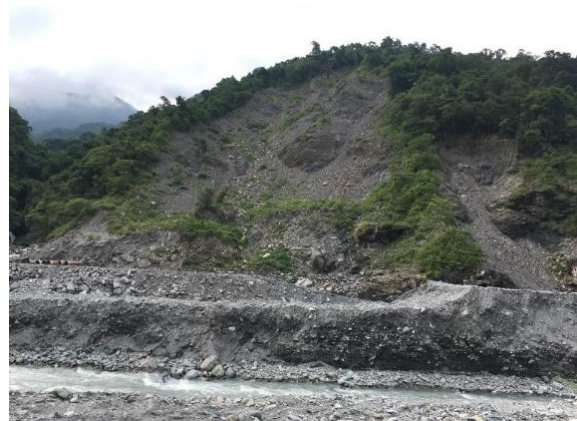
施工範圍堆高情形
