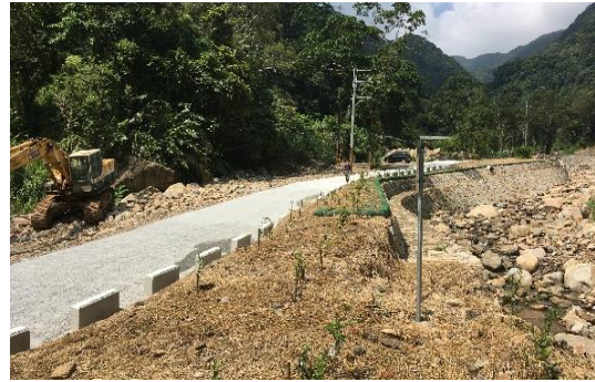
施工使用既有道路
