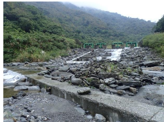
上游梳子壩與下方之數座連續混凝土固床工
