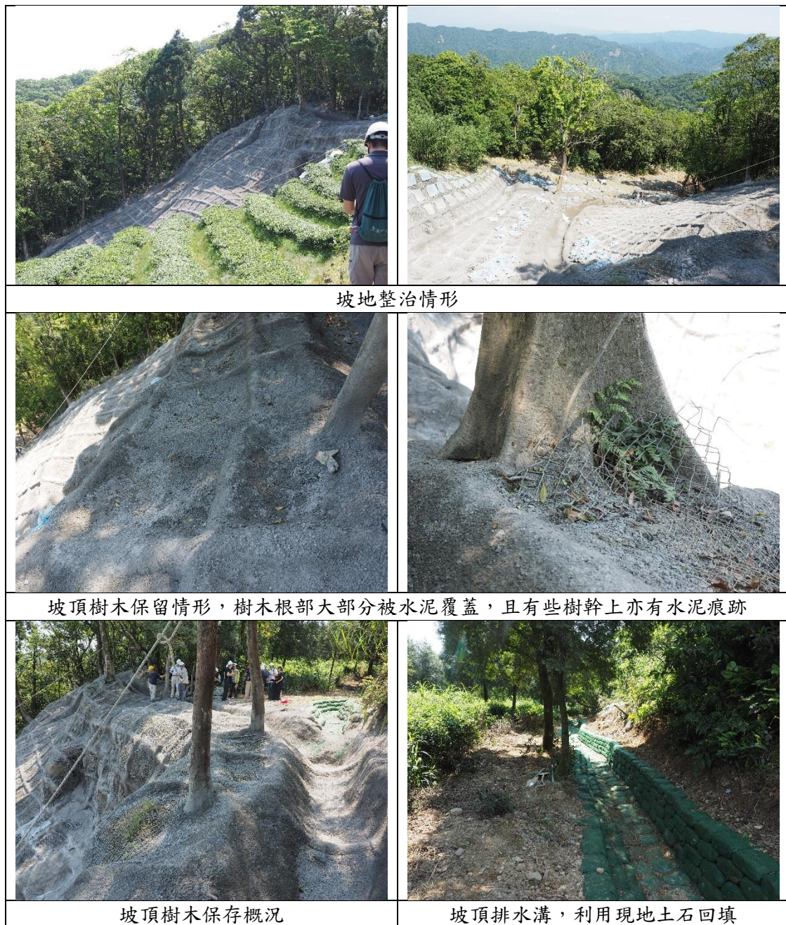
圖 7.2.1-2 石碇區風嘴崩塌地復育工程棲地施工階段狀況
