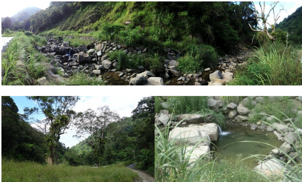
圖 7.2.2-1 平廣溪國有林地土石流 1 期防砂工程設計階段棲地現況
