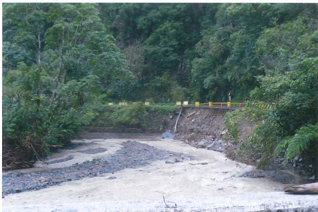
圖 4.4 蘇迪勒颱風後福山植物園聯外道路坍方樣貌。
