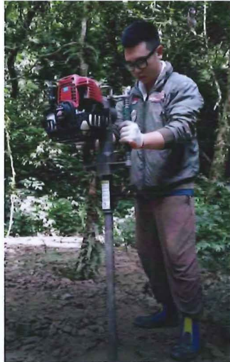
圖 5.22 採土打樁管現地測試 (2016/10/03)。
