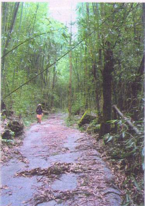
十字路到來吉的鄒族古道，大部分被 鋪上混凝土。
