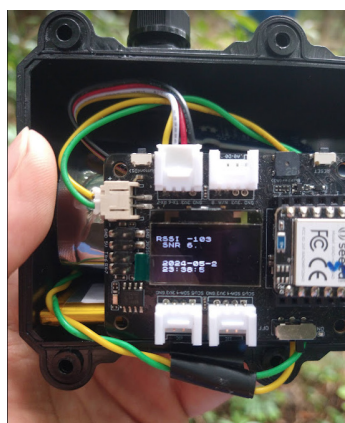
圖 51 用工具測試安裝地點 LoRa 訊號
