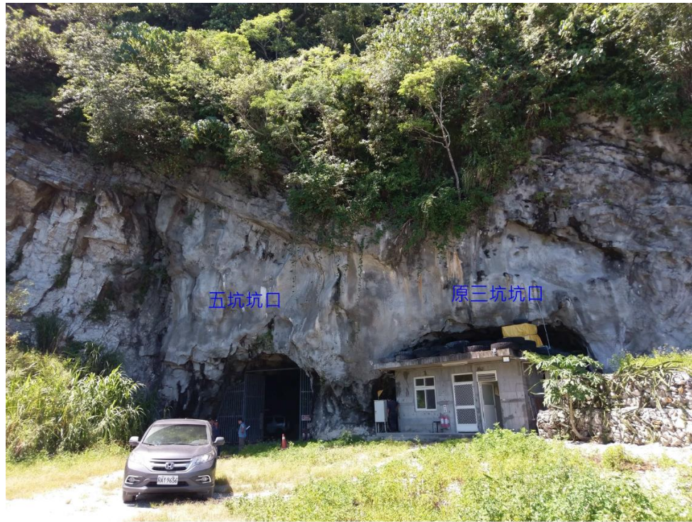
照片一現在儲礦場上方邊坡之採礦場已開採完畢，不再進行露天開挖，而儲礦場現況三坑坑口已興建一警衛室加以封堵，日後地下開採的坑口僅留存五坑坑口情形。
