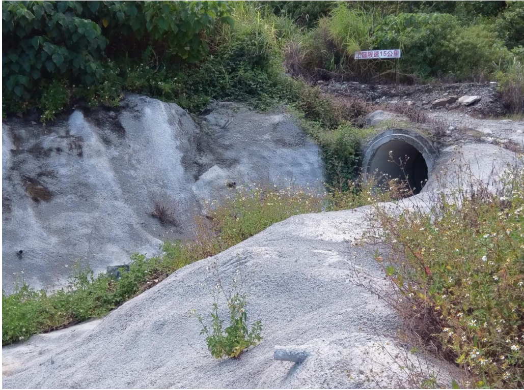
照片八 溝谷匯流下游處坡面噴漿防護情形一
