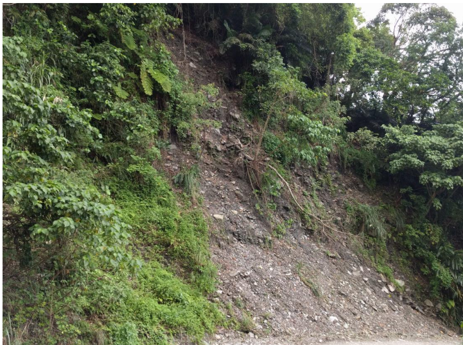
照片十 礦區東北側下邊坡火藥庫下游區域有深厚的崩積層情形
